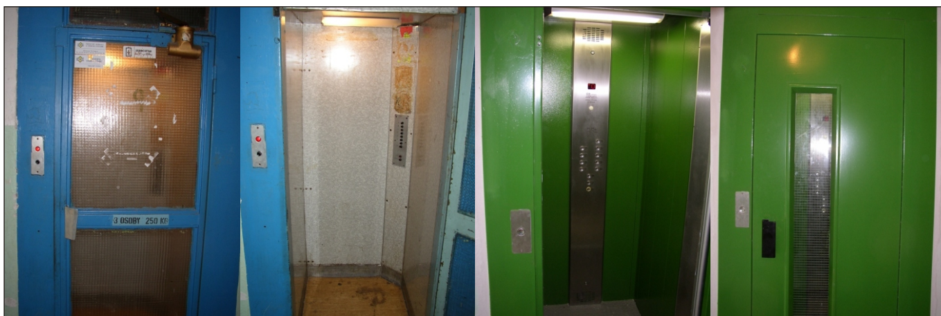
Vlevo (modrá) výtahová kabina před rekonstrukcí. Vpravo (zelená) výtahová kabina po rekonstrukci, kterou provedla odborná firma podle norem EU.
