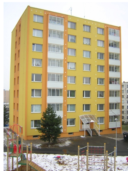
Rekonstruovaný panelový dům v ulici Krušnohorská 1661.
