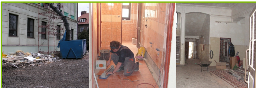
Stavební práce, které byly zahájeny v únoru 2008, by měly být dle plánu dokončeny ještě v květnu.
